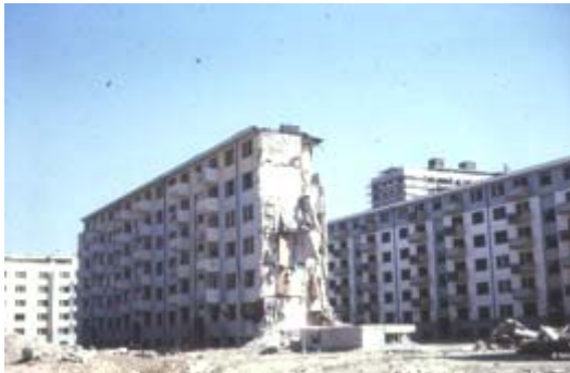
Şekil 2. 26 Temmuz 1963 Üsküp Depremi'nden sonra hasar görünüşleri: Üsküp'ün içinde betonarme bina hasarları (üstte), yığma bina bloklarından hasarlar (altta solda) ve Üsküp Tren İstasyonu'nun depremden sonraki hali (altta sağda). Resimler Ambraseys – IZIIS'den alınmıştır.
